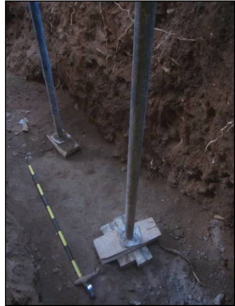
FOTO 18. Estrat UE 126 identificat a la cota màxima excavada a la cala R300
