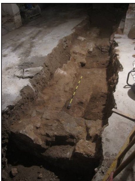
FOTO 23. Tram de la rasa R200 ampliada a petició del Servei d'Arqueologia Municipal. Podem veure, en primer lloc, el mur UE 119 i, just darrera, els murs UE 120 i UE 135 (aquest sota el jaló)
