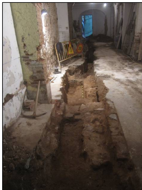
FOTO 24. Vista general mirant cap al NE del tram ampliament de la rasa R200
