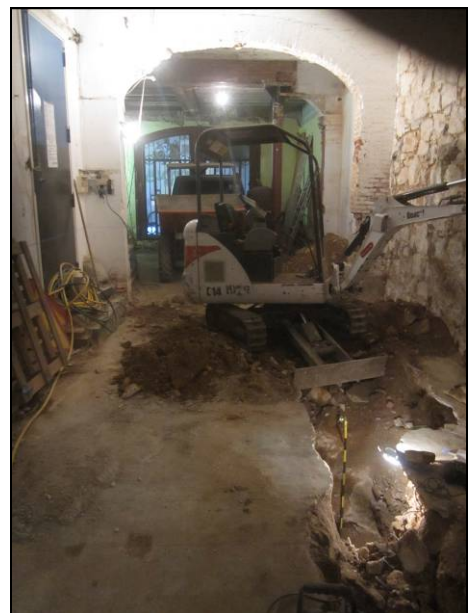
FOTO 20. Vista general de la cala efectuada a tocar de la cara NE del mur UE 119 (R200)
