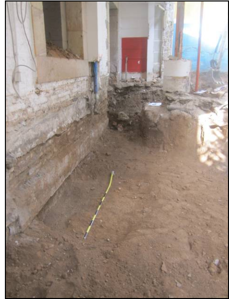
FOTO 6. Retall de construcció de la façana posterior de la finca (UE 103)
