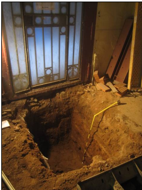
FOTO 27. Vista general de la cala R500
