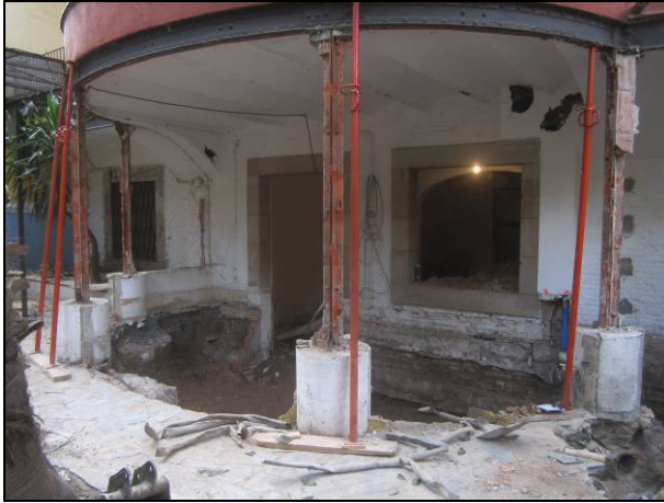
FOTO 5. Cala R300 excavada per a instal·lar nous pilars a la tribuna sobre una nova fonamentació de formigó armat
