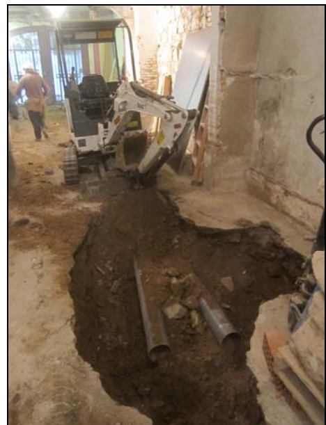
FOTO 40. Cala per a situar dues arquetes R600 un cop excavada
