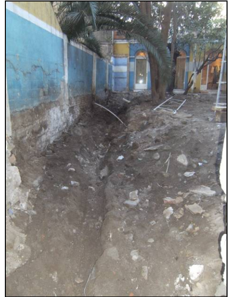
FOTO 10. Vista de la rasa R100
