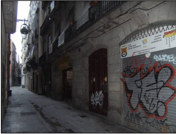
FOTO 1. Vista de la façana de l'immoble on s'ha desenvolupat la intervenció arqueològica
