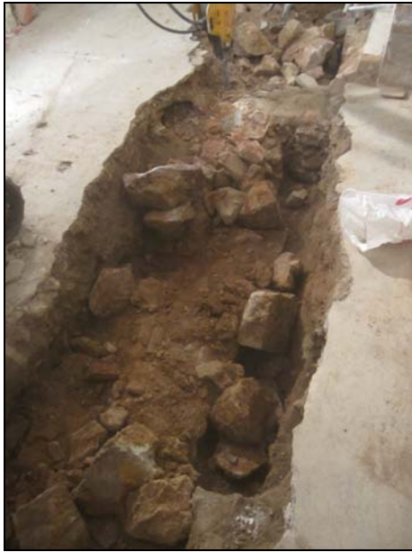
FOTO 37. Desmuntatge del mur UE 120
