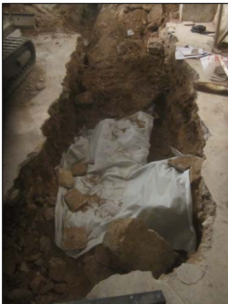
FOTO 39. Cobriment dels murs UE 119 i UE 135
